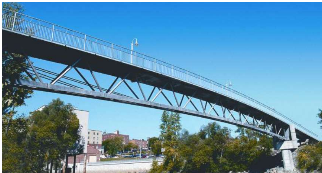
Obr. 22 Lávka Sherbrook ve Francii, příhradová konstrukce z UHPC
