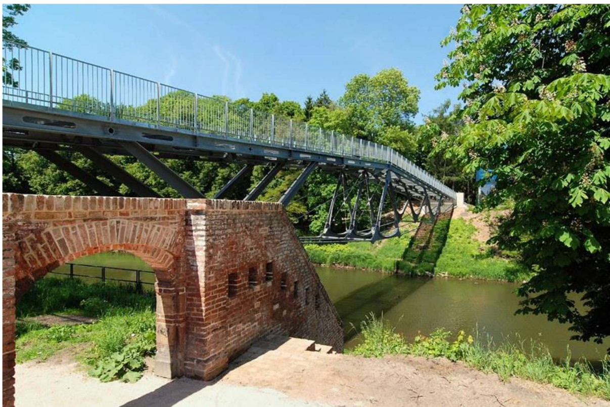
Obr. 17 Příhradová lávka z roku 2013 v Hradci Králové
