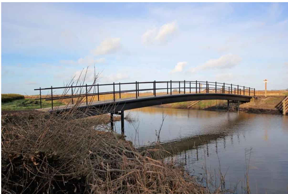
Obr. 18 Trámový most Anny Pavlovny z CFRP
