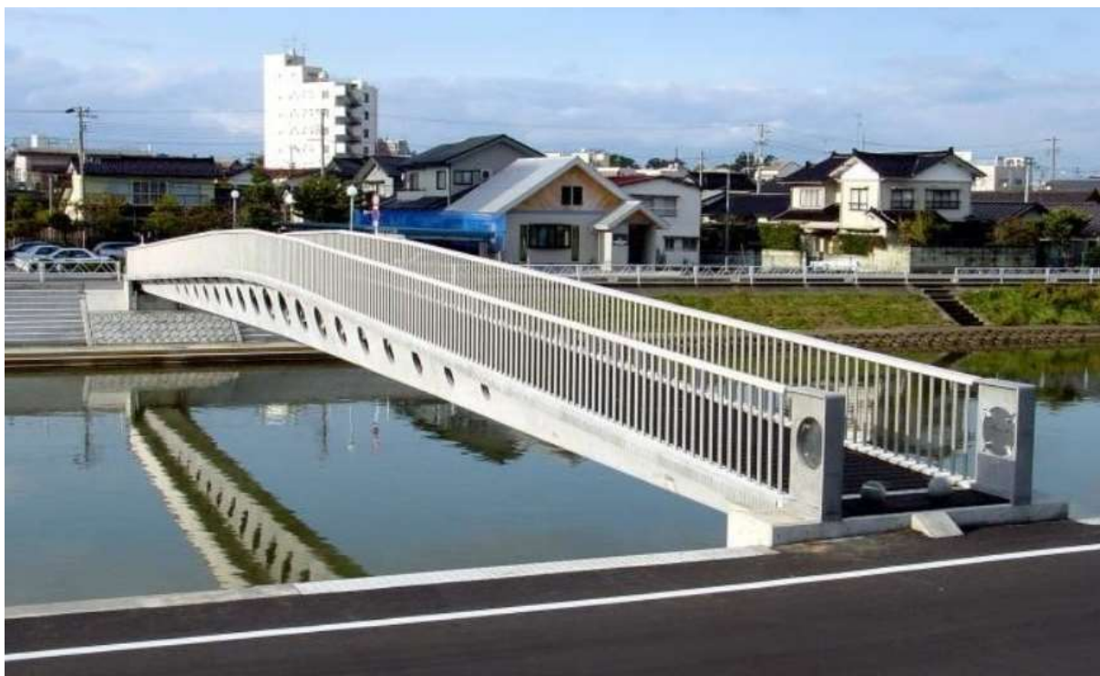
Obr. 23 Lávka Sakata Mirai v Japonsku – hlavní NK o rozpětí 50 m z UHPC
