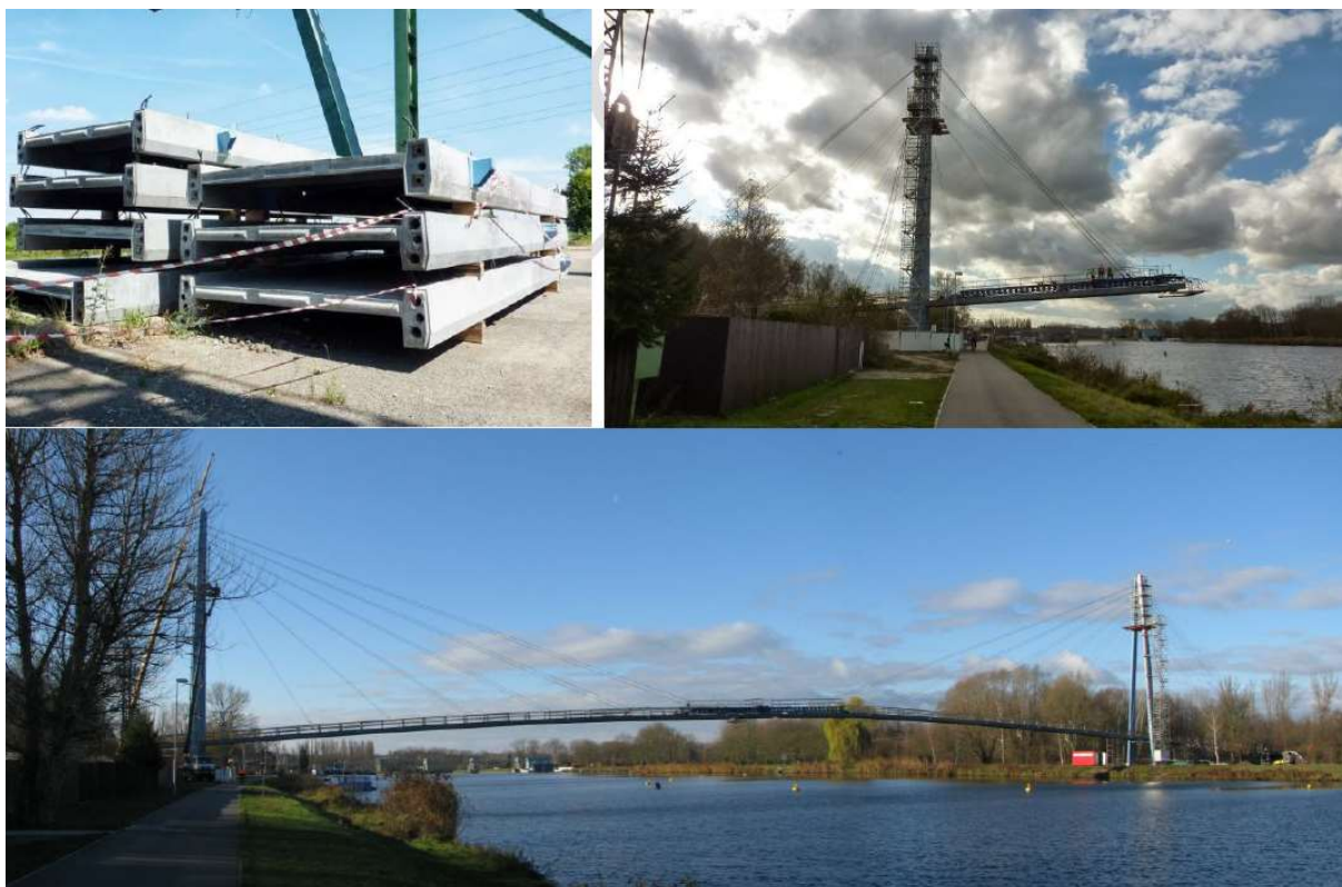
Obr. 21 Lávka přes Labe Čelákovících – mostovka z předepjatých UHPC segmentů
