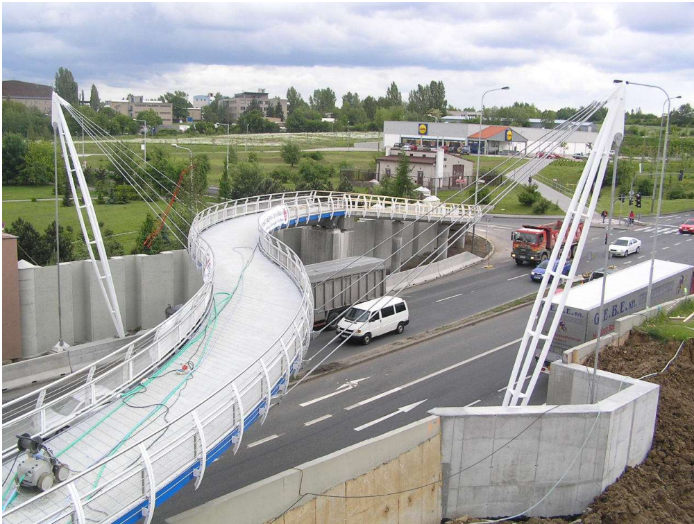
Obr. 1 Lávka na ulici K Barrandovu
