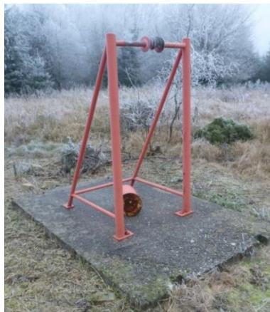
Obr. 3: Pohled na poškozený kyvadlový tlumič Fig. 3: A view of the broken pendulum damper
