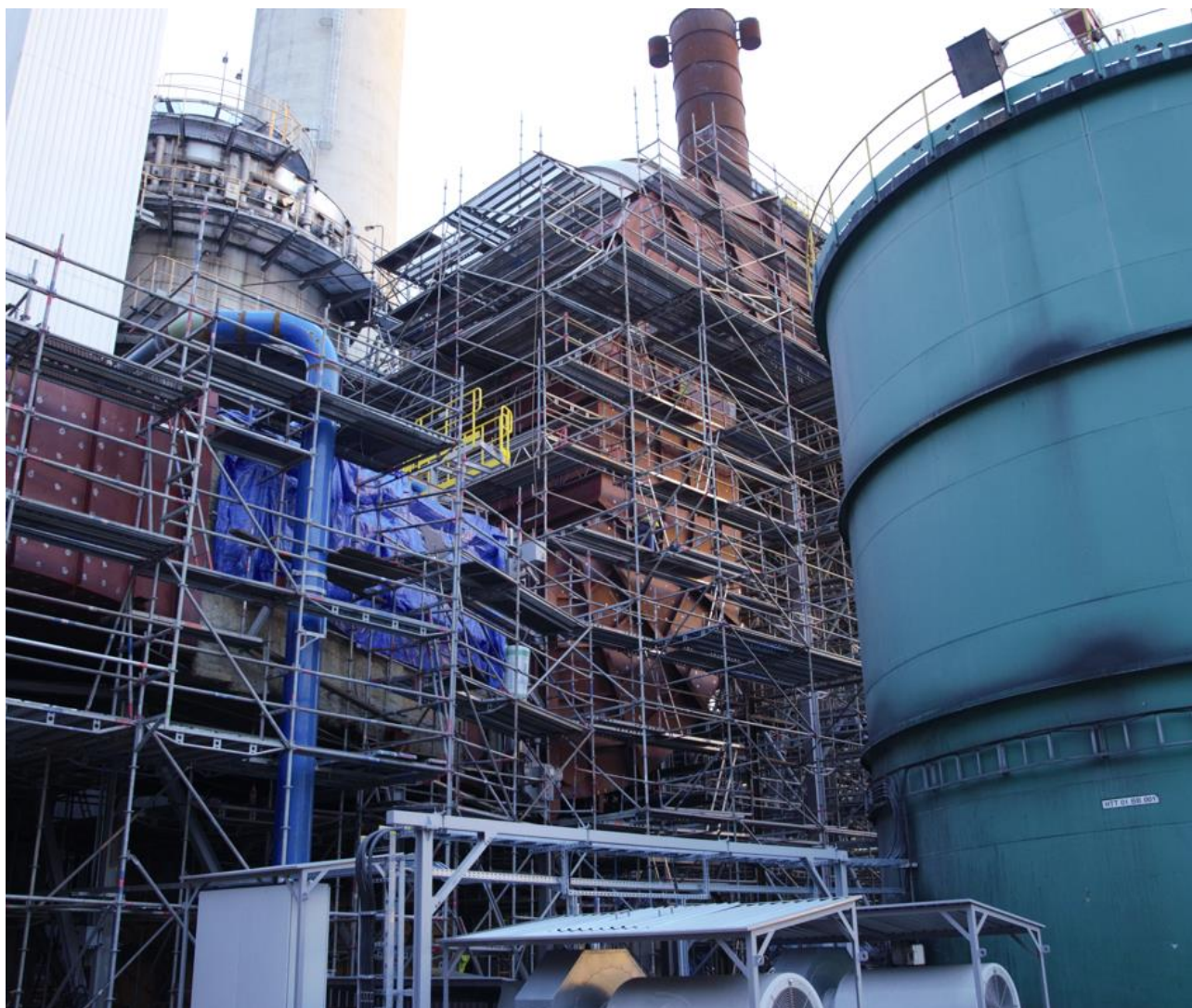
Obr. 3 Montáž kouřovodu 15
