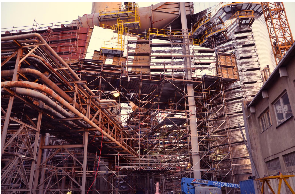
Obr. 4 Montáž kouřovodů navazujících na řešený úsek
