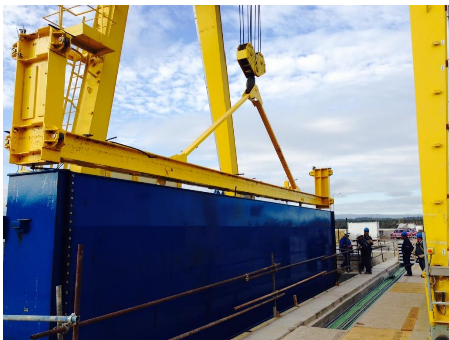
Obr.3 – Instalace hradicích elementů do tělesa hráze
