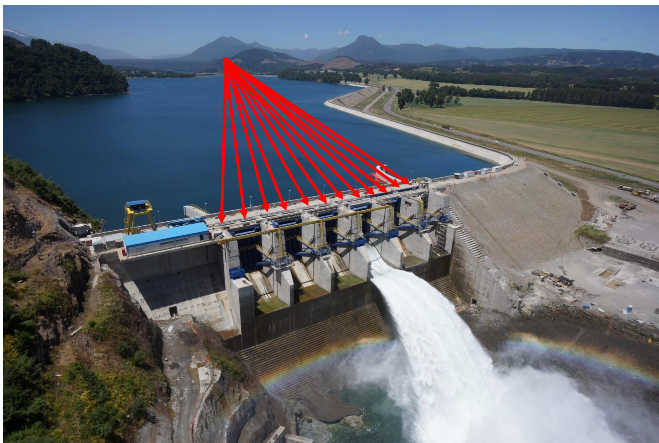
Obr.4 – Přehrada; šipky naznačují místa instalace hradicích systému dle Obr. 3, zpravidla se ale hradí v jednom čase pouze jeden vtok. Hradicí elementy, pokud zrovna nehradí vtok, se skládají ve vrcholech instalačních slotů.
