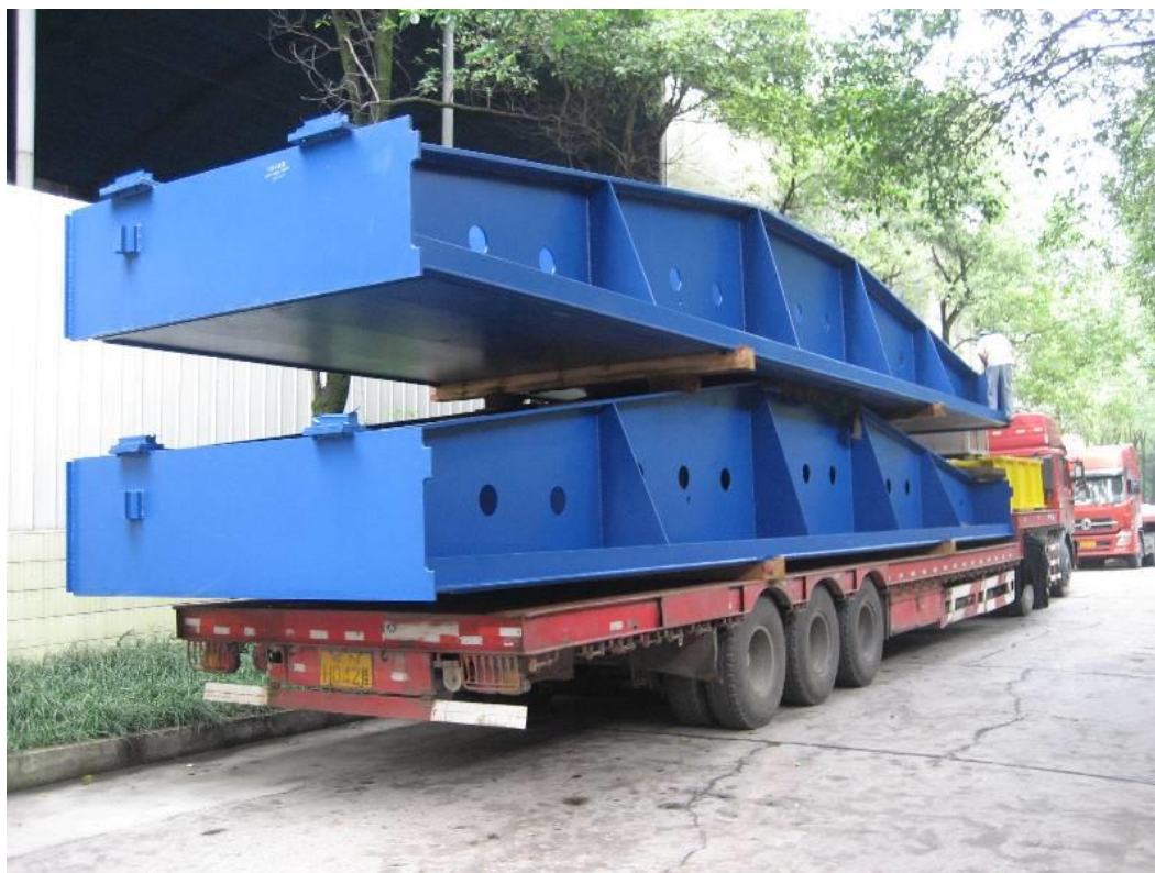
Obr.2 – Transport hradicích elementů
